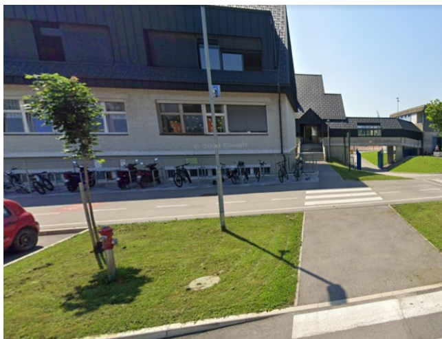
Zunanji nadtalni hidrant – pred vhodom v objekt
